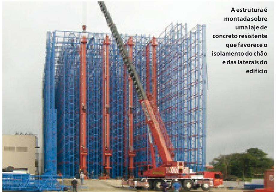
A estrutura é montada sobre uma laje de concreto resistente que favorece o isolamento do chão e das laterais do edifício
