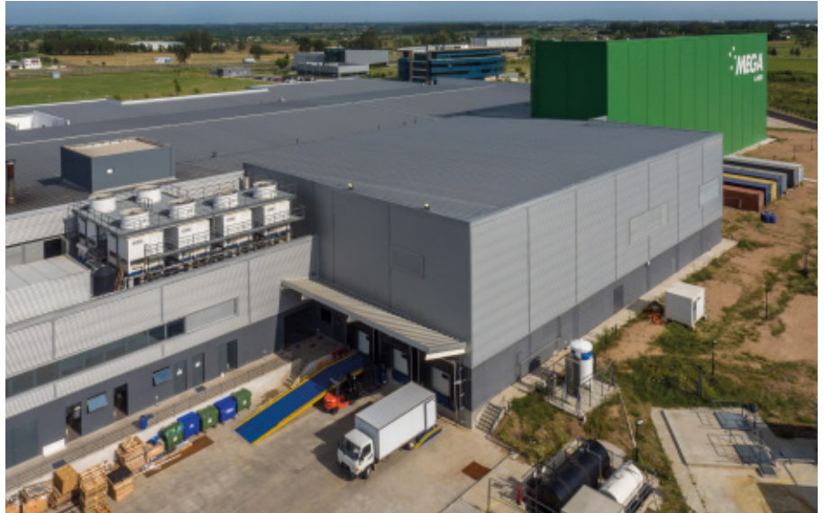
As docas de carga e descarga estão separadas com a finalidade de evitar interferências entre ambas as operações
