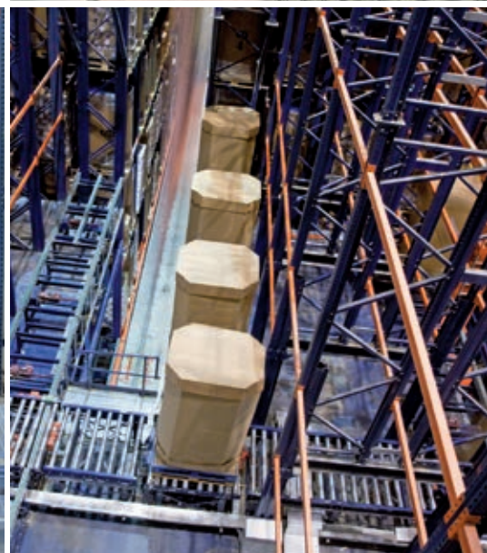
Transportadores de corredor de armazenamento.
