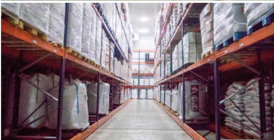
A Mecalux equipou três câmaras de congelamento da Frío Valencia com estantes sobre bases móveis Movirack. Este sistema aproveita toda a superfície disponível para proporcionar uma capacidade de armazenamento superior a 7.700 paletes e, por sua vez, oferece acesso direto às referências no momento de abrir um corredor de trabalho.
