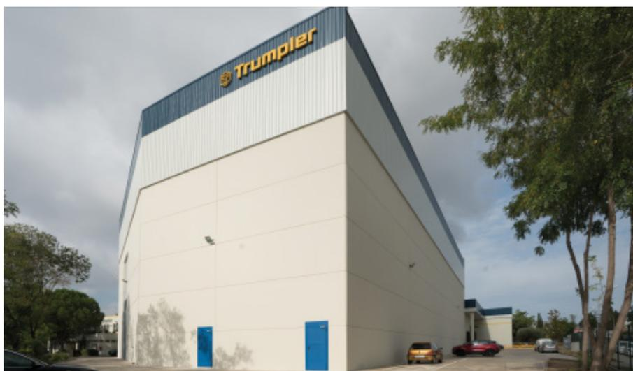
mizar ao máximo o espaço disponível, o galpão foi projetado tendo como base as dimensões do armazém automático, ou seja, primeiro foram desenhadas as estantes e, posteriormente, construído o galpão. Desta forma, a Trumpler obteve uma capacidade de armazenamento para 2.512 paletes de matérias-primas e produtos acabados.
