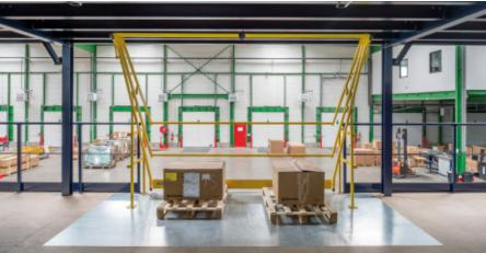
calizações. Em cada piso foram instaladas docas de descarga de paletes através de portas de batente de segurança.
