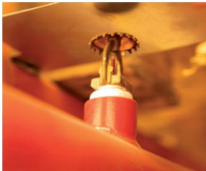
Os sprinklers automáticos (fire sprinklers) foram distribuídos estrategicamente no interior das estantes em função da carga de fogo.
